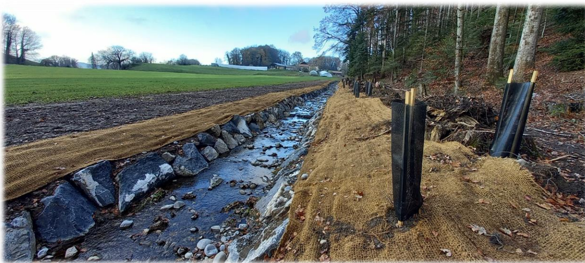
Etanchéification du ruisseau « La Salenche »
