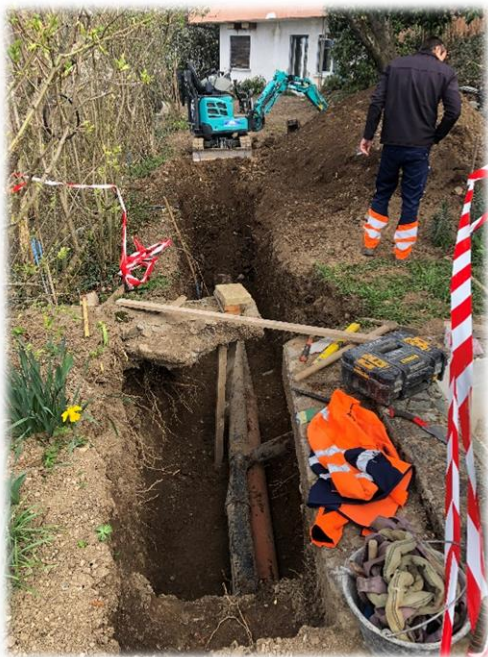
Remplacement des collecteurs « eaux usées » au Ch. de la Croix
