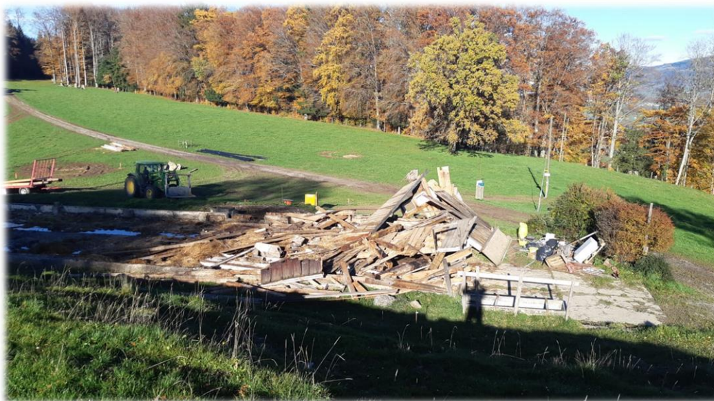
Démolition du chalet de la Moille
